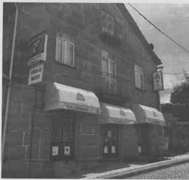
Ladrões forçaram a entrada no restaurante pelo telhado
